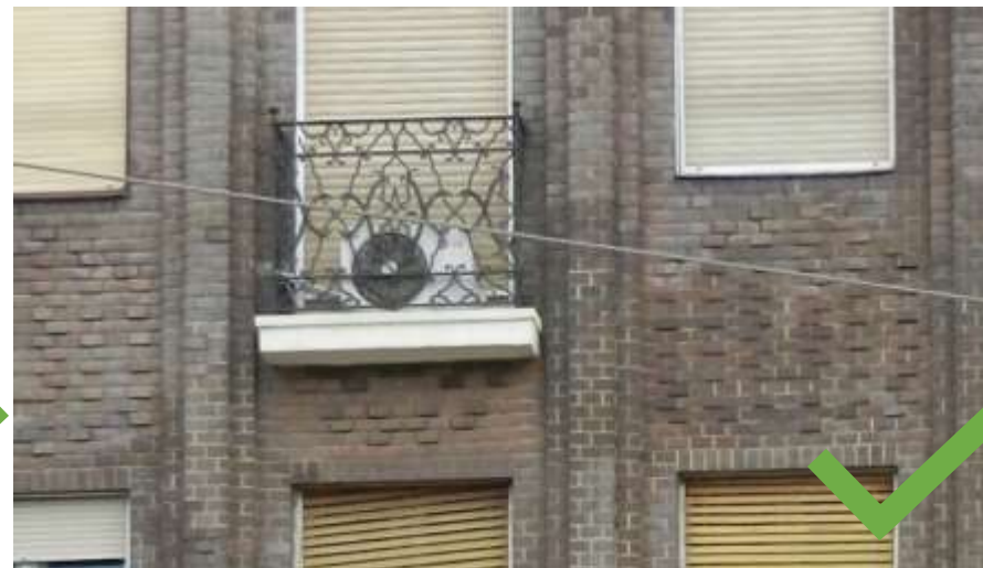
Klíma kültéri egységének elhelyezése a Madách-házakban.
