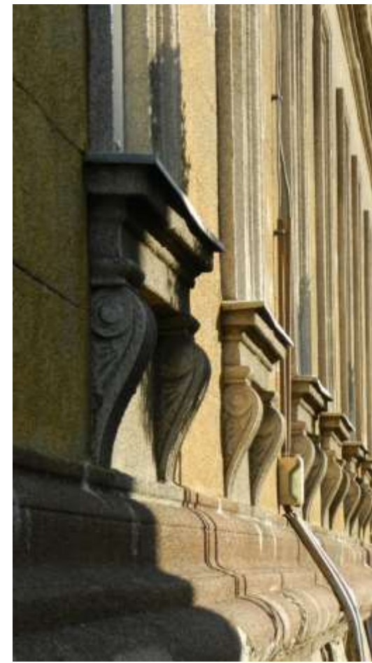
Plasztikus homlokzat a Dohány utca 79-ben
