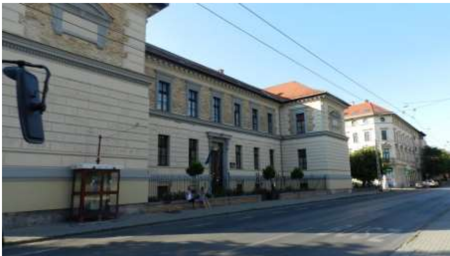
Kerítés a Rózsák terénél
