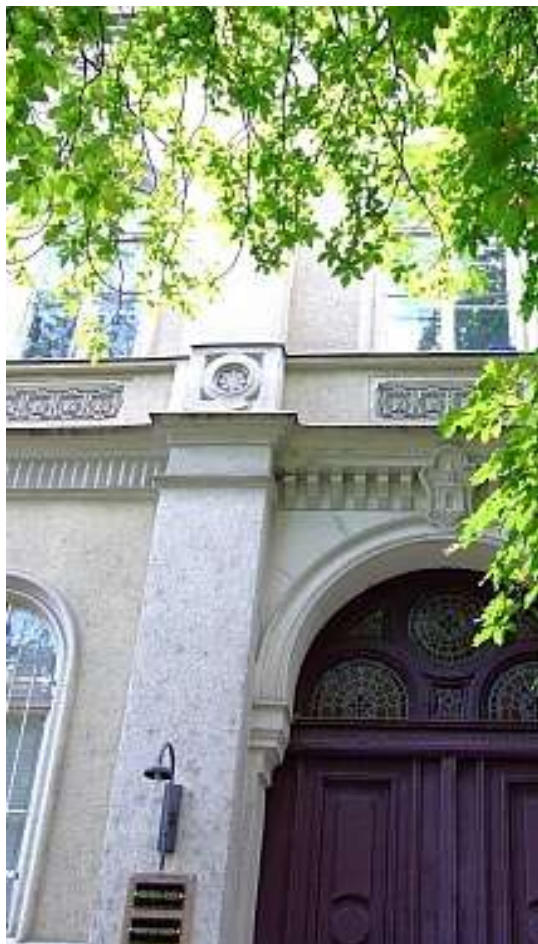
volt Erzsébet Leányárvaház cím: Rottenbiller utca 50., hrsz: 33824 épült: 1870-72 tervezte: Vassél Alajos Erzsébet Leányárvaház céljára létesült emeletes, szabadon álló, romantikus ház
