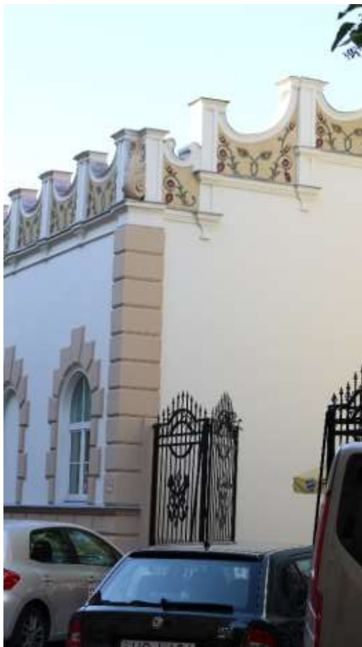
Haggenmacher-sörgyár raktárai cím: Huszár u. 7-9., hrsz: 33563 épült: 1863, 1871, 1935 tervezte: Friedmann Ernő (1935) Felújított, ma Buddhista központ működik az épületben. Eredetileg 2 műhely, és lakóház állt.
