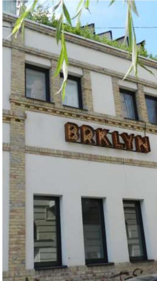
Felújított egykori trafóház
